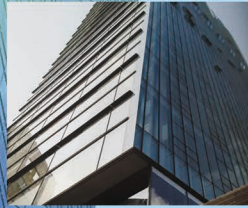
현대캐피탈 부산사옥 썬팅필름 시공
